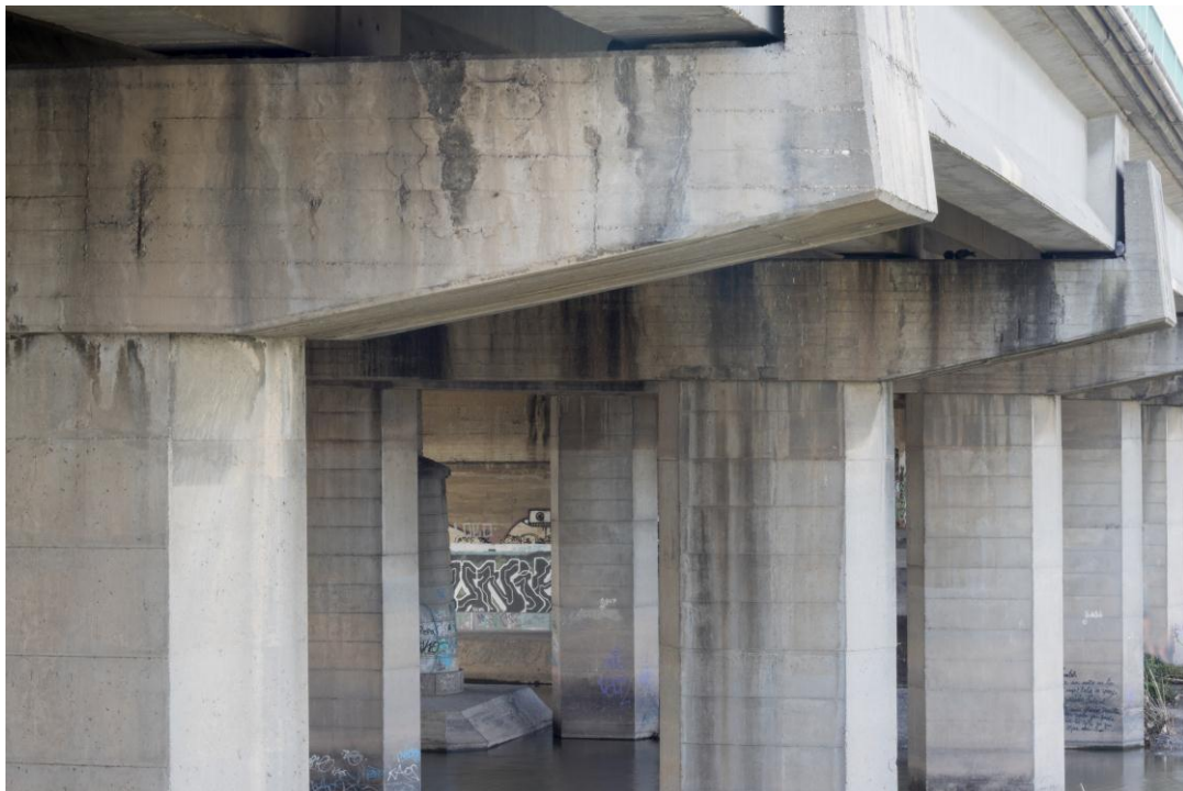
Image 1. Pont Sobre Llobregat. Jonathan Beresford.
